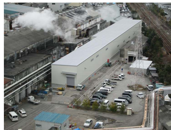
フィブリック 建屋建設
