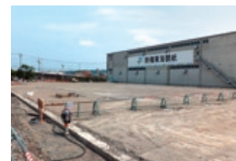
東海加工紙(株)本社工場建設の様子
