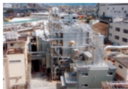
三島工場新ボイラ建設の様子
