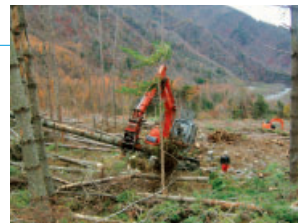
復旧作業の様子
