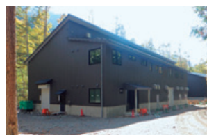
建設中の井川蒸溜所外観
