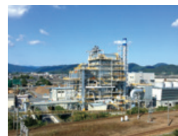
新東海製紙(株) バイオマスボイラー
