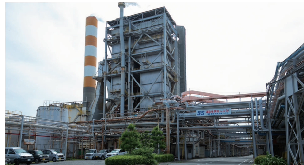
黒液回収ボイラ
