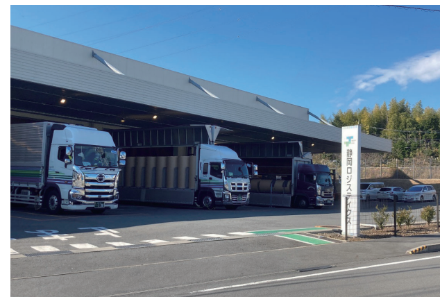
静岡ロジスティクス物流センター
