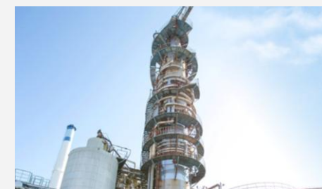
カミヤ式連続蒸解釜 (パルプ生産設備)
