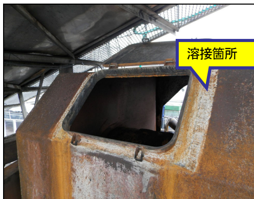
図4. 点検窓の外観 (点検窓の大きさ: 縦 40cm、横 50cm、蓋の重さ: 約 3kg)
