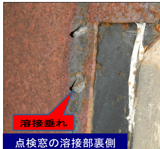
図 9. 点検窓溶接部裏側
