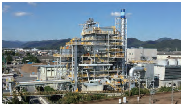
新東海製紙島田工場12号バイオマスボイラ
