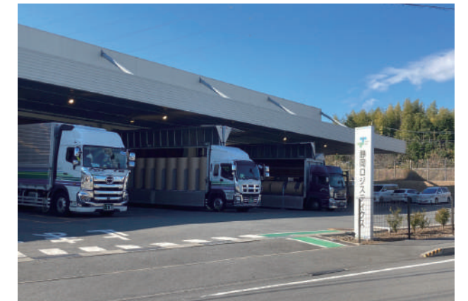
静岡ロジスティクス物流センター
