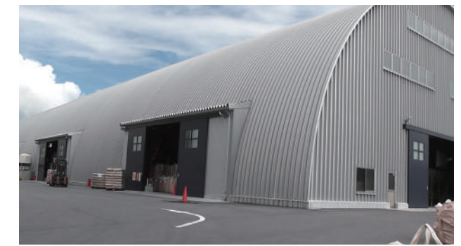
Port Dream Factory (硬質プラスチック再原料化工場) 外観
