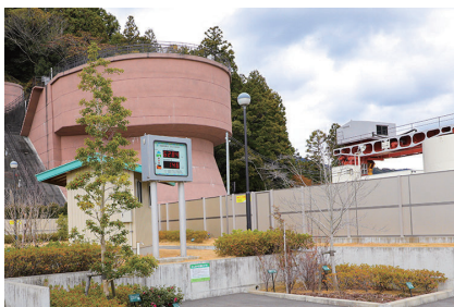
▲赤松水力発電所
