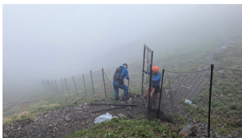
▲防鹿柵の設置
