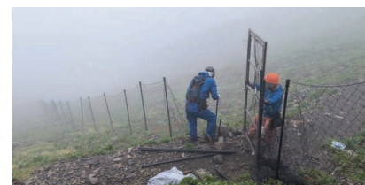
防鹿柵の設置
